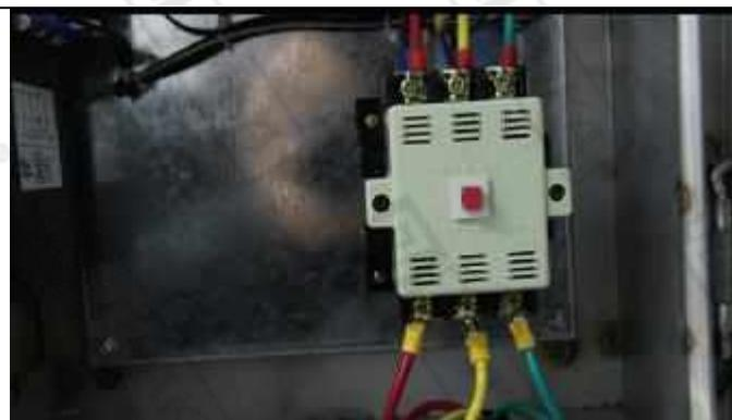
Картинка слева – схема подключения с контактором переменного тока. (Затяжка проводов снизу контактора, нет особых порядков цветов провода).
