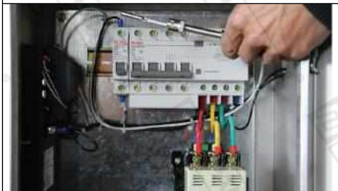
Откройте электрический блок управления и выньте датчик температуры. Датчик температуры используется для определения температуры внутри печи. Вставьте датчик в отверстие рядом с блоком управления и зафиксируйте его.
