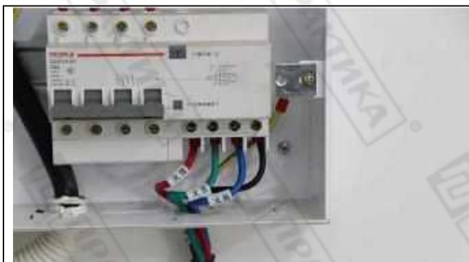
Слева пример подключения. Три фазовых провода, провод заземления и зануления. Провода должны быть определены и помечены.
